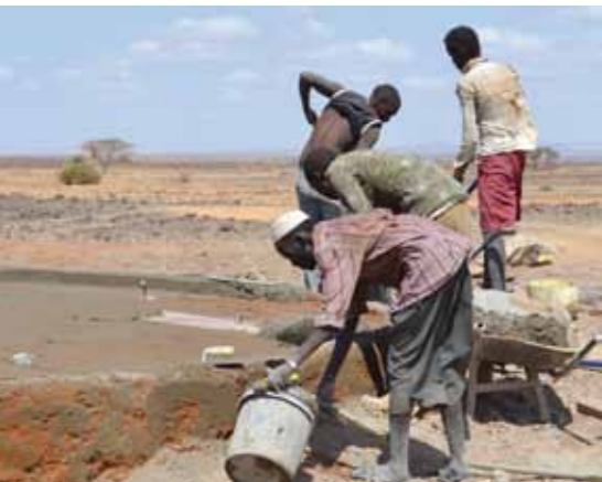
Bau eines Untergrund-Wassertanks; Foto: G. Hödl
